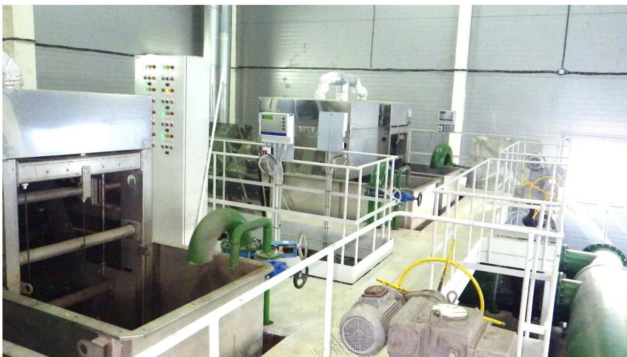
Рисунок 1. Помещение грубой механической очистки. Автоматические сорулавливающие решетки
