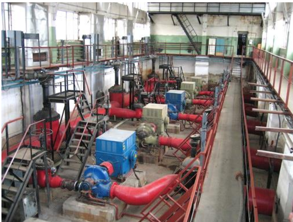
Рисунок 6. Машинный зал насосной станции очищенных сточных вод
