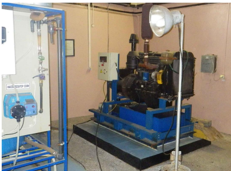
Рисунок 9. Дизель-генераторная установка
