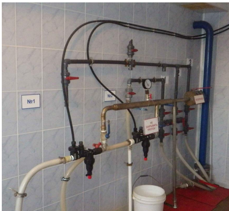
Рисунок 7. Эжекторы подачи хлора
