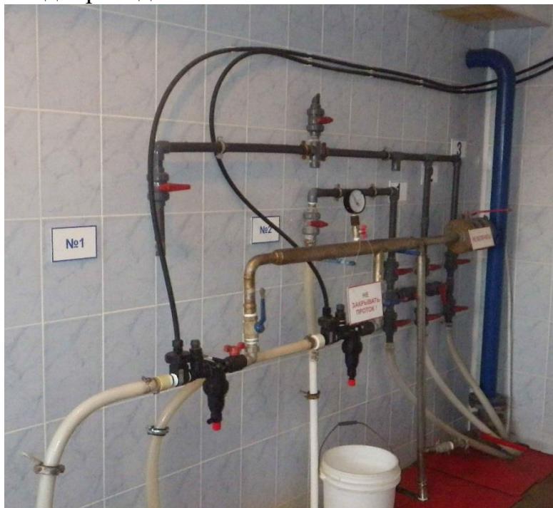
Рисунок 7. Эжекторы подачи хлора
