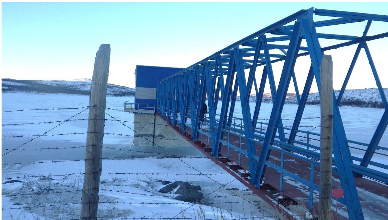
Рисунок 3. Водозаборная башня со служебным мостом
