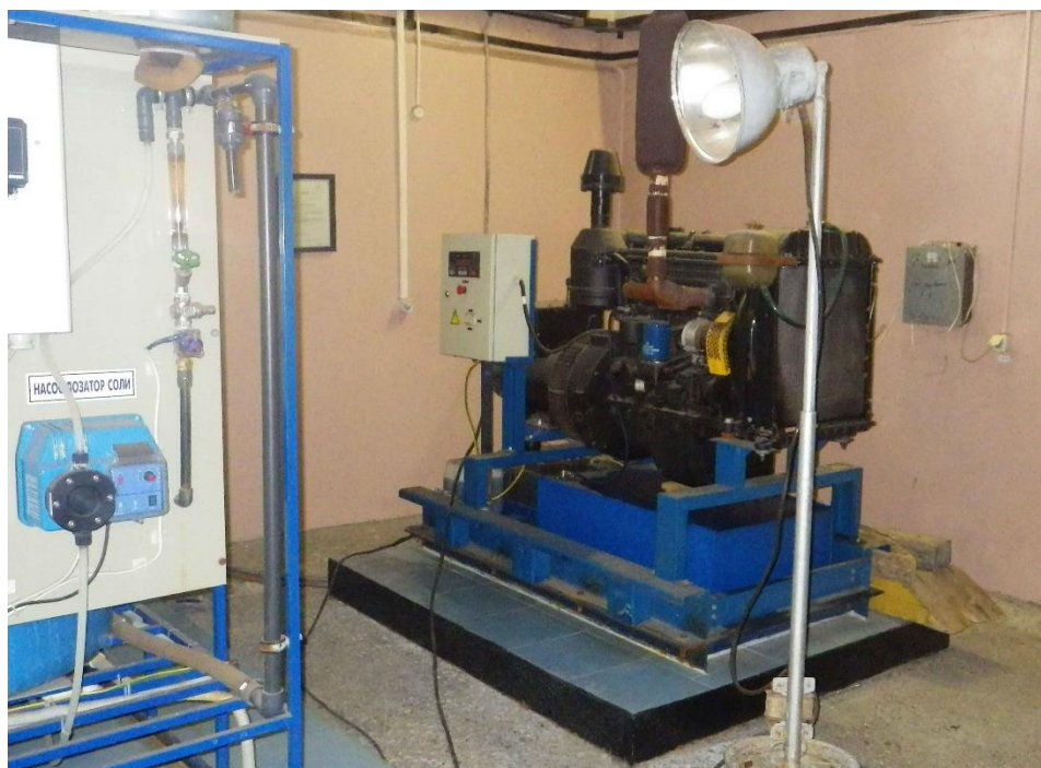
Рисунок 9. Дизель-генераторная установка
