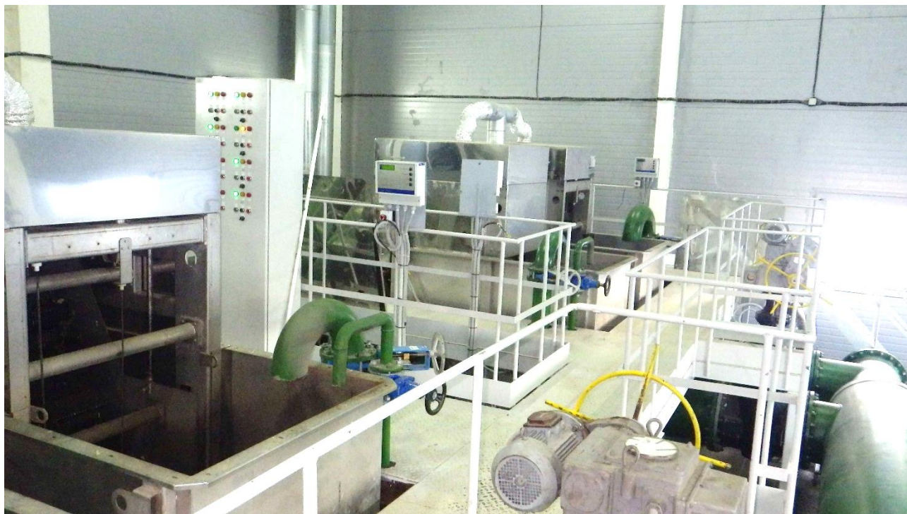
Рисунок 1. Помещение грубой механической очистки. Автоматические сороулавливающие решетки
