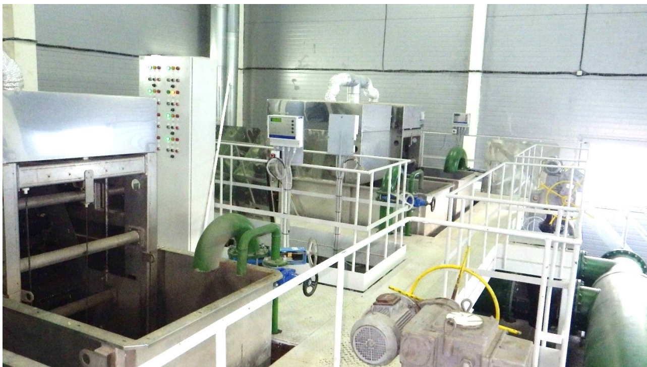
Рисунок 22. Помещение грубой механической очистки. Автоматические сорулавливающие решетки
