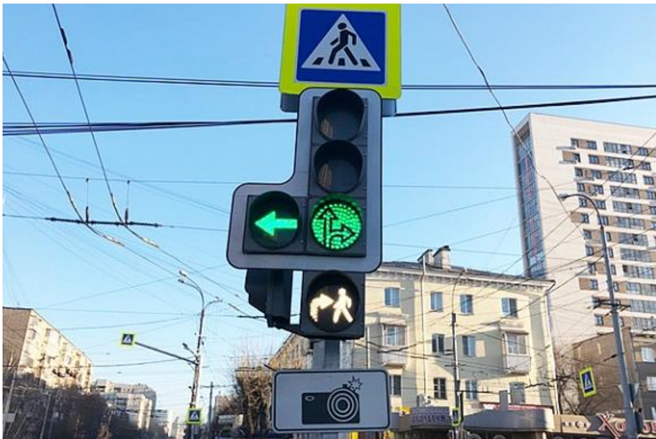
Рисунок 3.3.9 – Пример применения информационной световой секции бело-лунного цвета с изображением пешехода (по ГОСТ Р 52289-2019)
