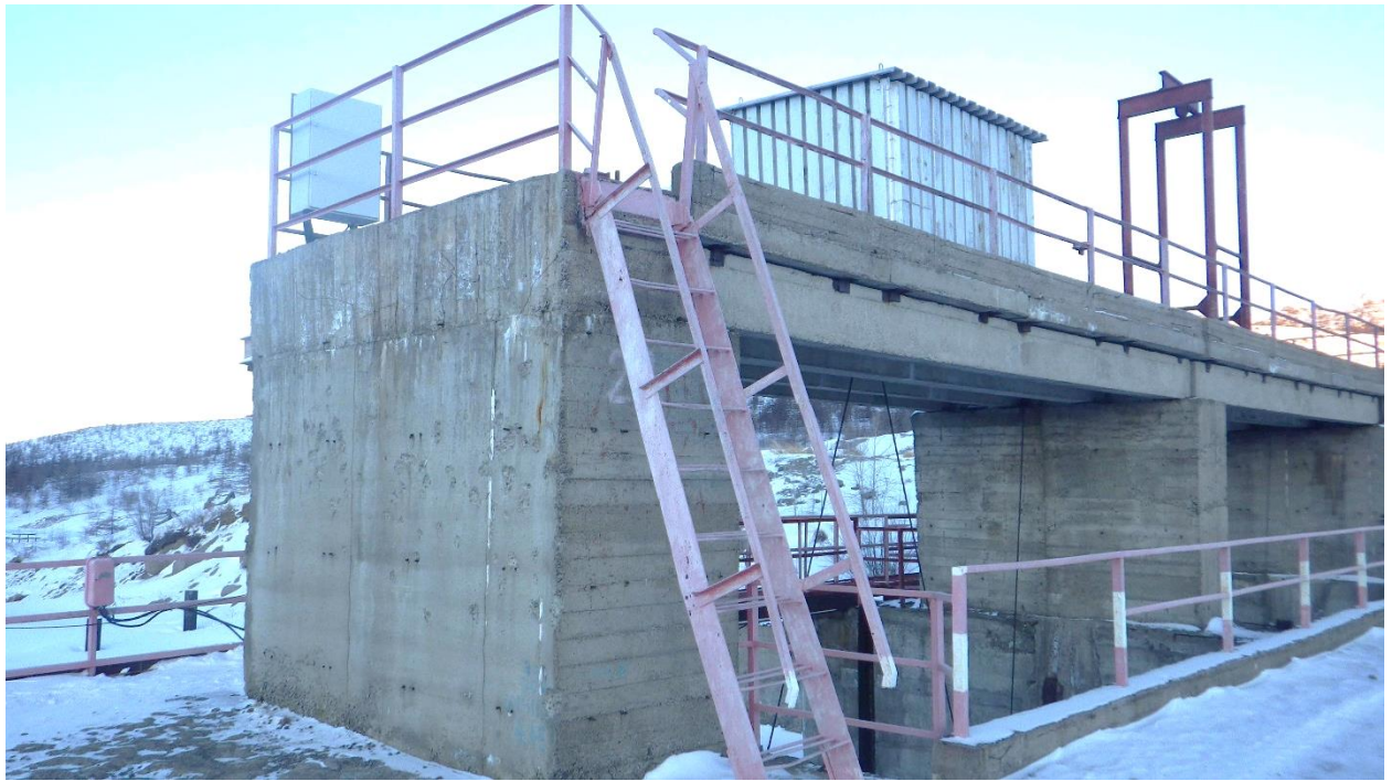
Рисунок 2. Паводковый водосброс
