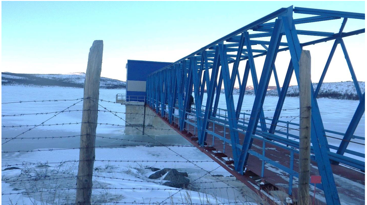
Рисунок 3. Водозаборная башня со служебным мостом
