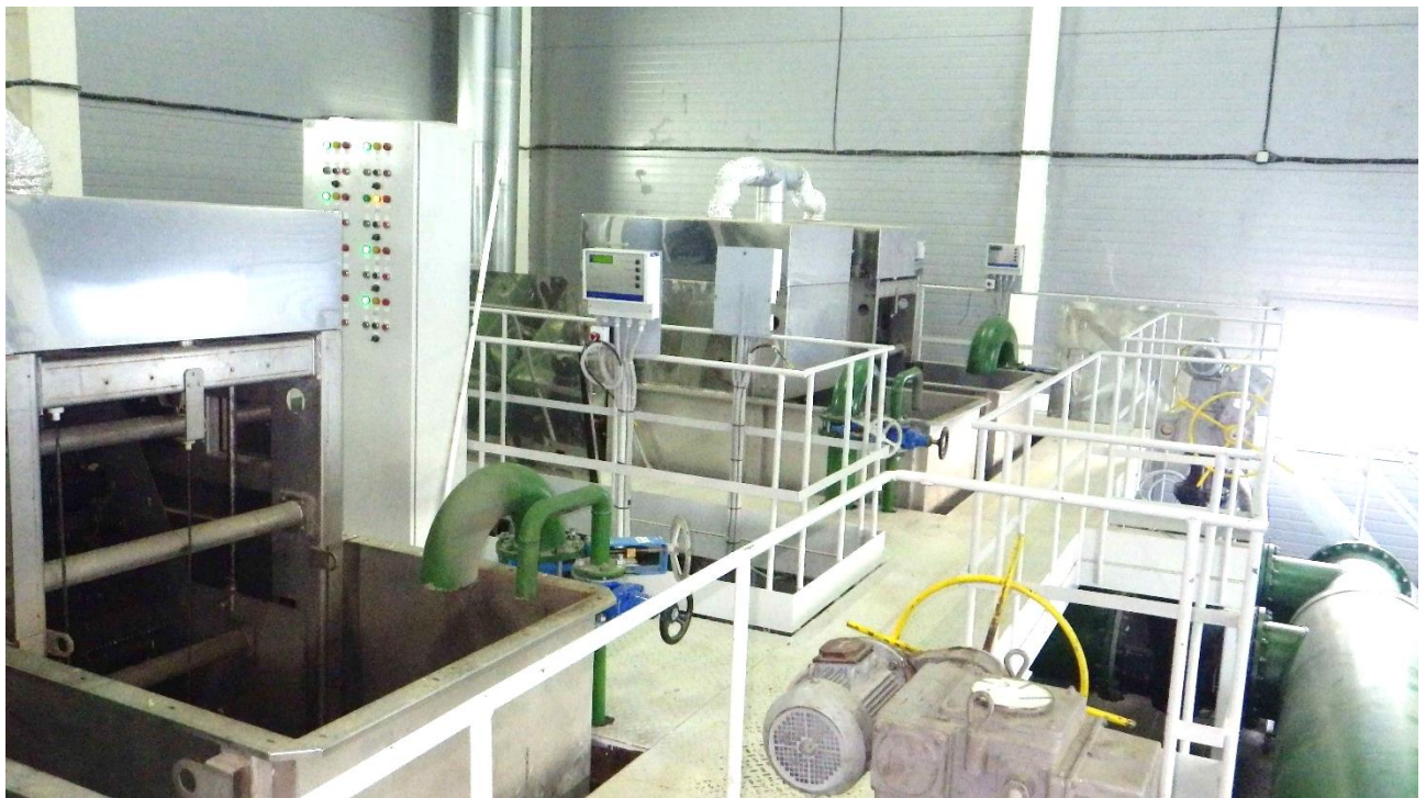
Рисунок 1. Помещение грубой механической очистки. Автоматические сорулавливающие решетки
