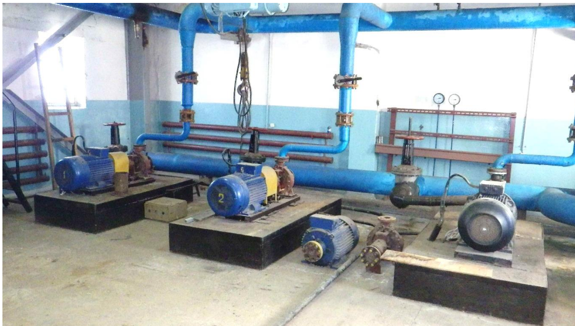
Рисунок 13. Машиный зал ВНС 2-го подъема в мкр. Пионерный
