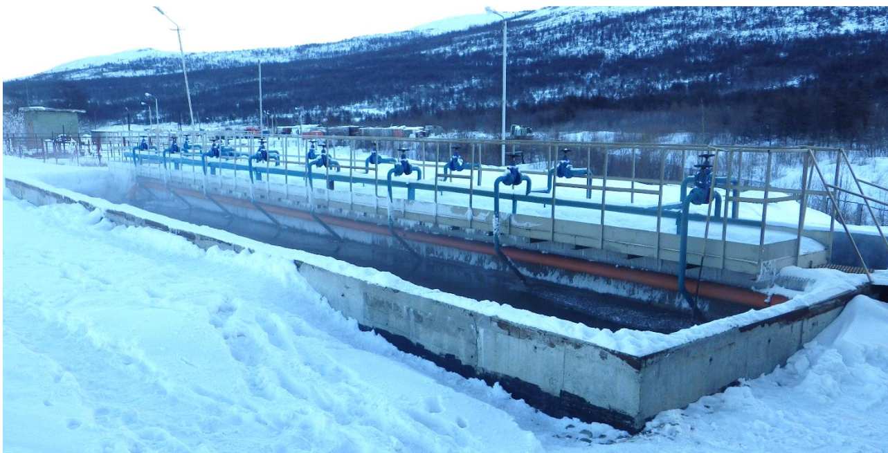
Рисунок 2. Песколовки
