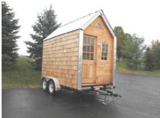
Рисунок 1 – Полномасштабная модель конструкции, созданной из мицелиевых композитов
