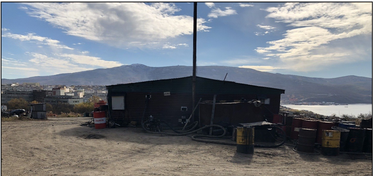
Рис. 3. Цех переработки нефтепродуктов
